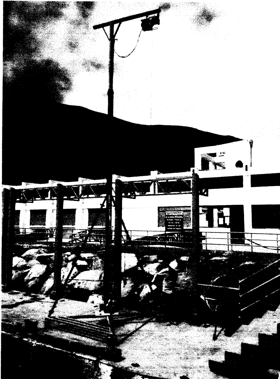
Fotografía N°01: Vista de izado y montaje de tijerales para estructuras metálicas.
