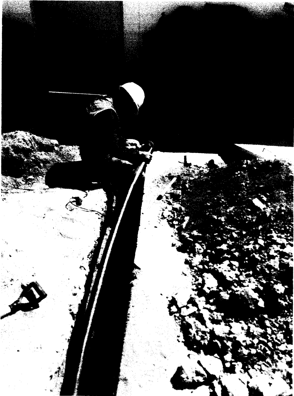
Fotografía N°09: Vista de trabajos de acople de tubería HDPE del adicional de obra.
