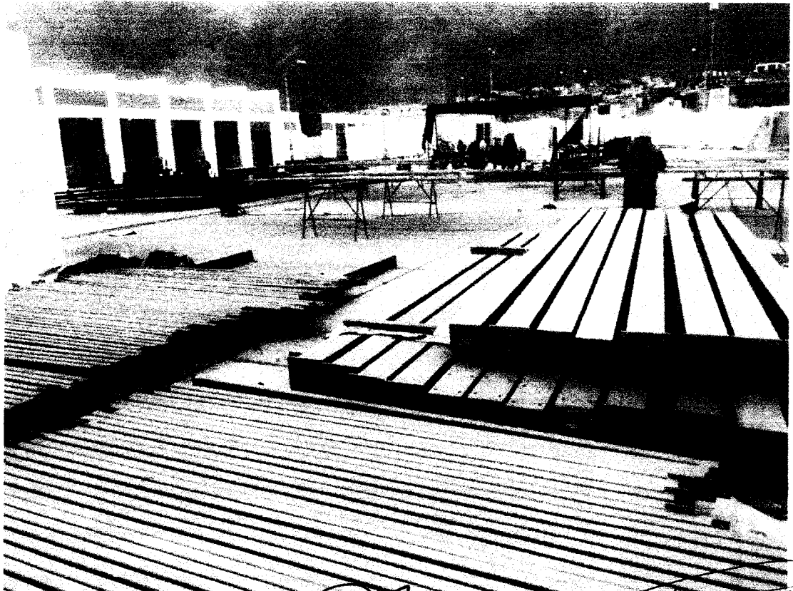
Fotografía N°06: Zona de secado de pintura.
