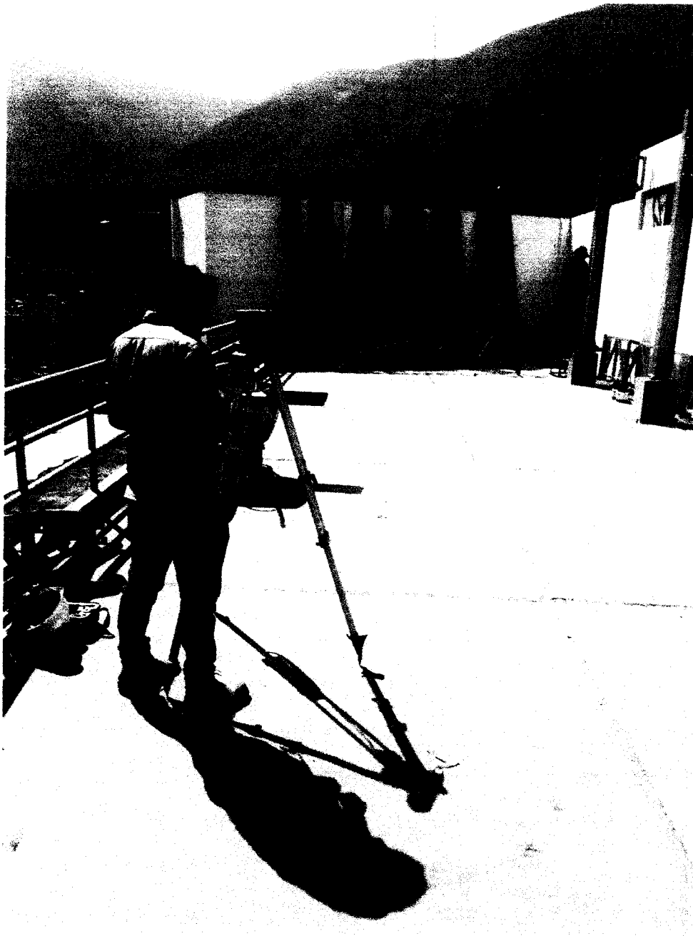
Fotografía N°08: Vista de control de nivel horizontal y verticalidad de estructuras para cobertura tipo I.
